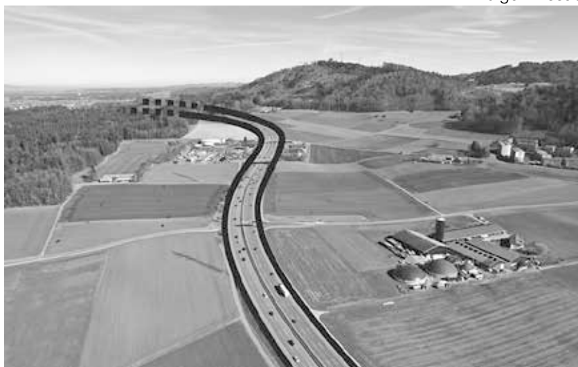
Verbreiterung der Autobahn auf 8 Spuren vom Wankdorf bis Schönbühl (Bild: spurwechsel-bern.ch)
