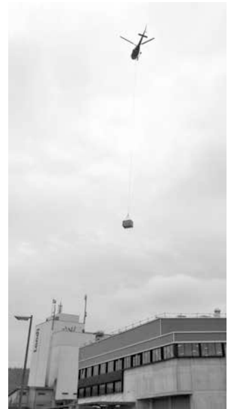
Die Last schwebt in luftiger Höhe auf das Dach
