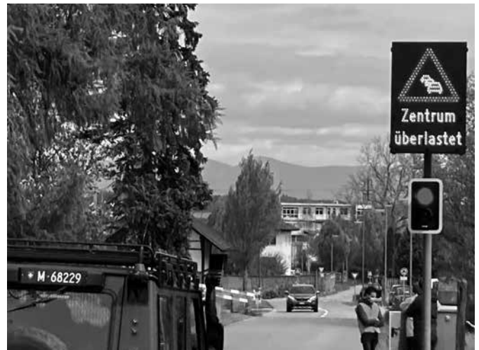
Funktionstest der neu installierten Dosieranlage an der Sandstrasse Urtenen-Schönbühl (Bild: R. Beyeler, TBA)
