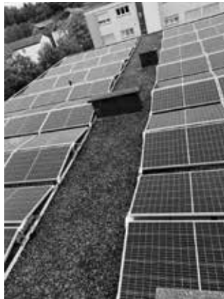
Durch den Eigenverbrauch amortisiert sich diese Photovoltaikanlage in 16 Jahren. Auf die Lebensdauer ergibt sich eine Rendite von knapp 2,5%
