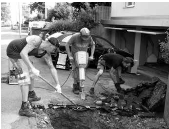
Asphalt wird mit dem Presslufthammer abgebaut
