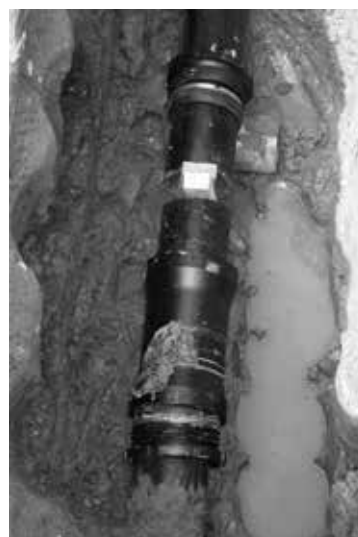
Noch müssen die Verschraubungen angezogen werden
