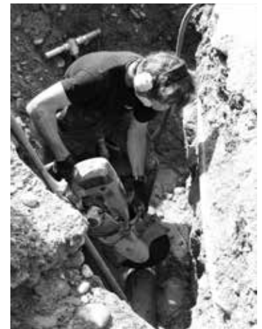
Mit dem «Trennjäger» wird das defekte Rohrstück herausgeschnitten
