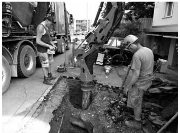
Raphael Böck (ERNE AG) steuert das Saugrohr, Markus Dürig gibt Anweisungen zum Aushub
