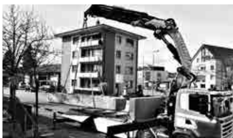
Der 8 Tonnen schwere Brunnentrog hängt am Kran
