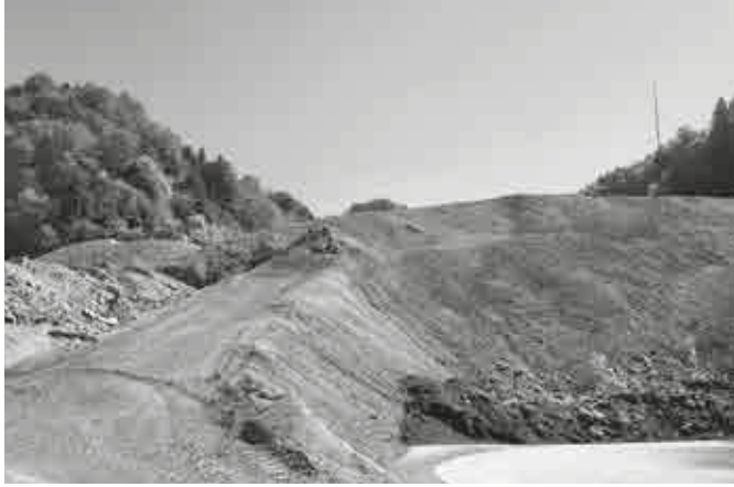
Professionelle Talaustrückfüllung mit Schlacke und Flugasche
