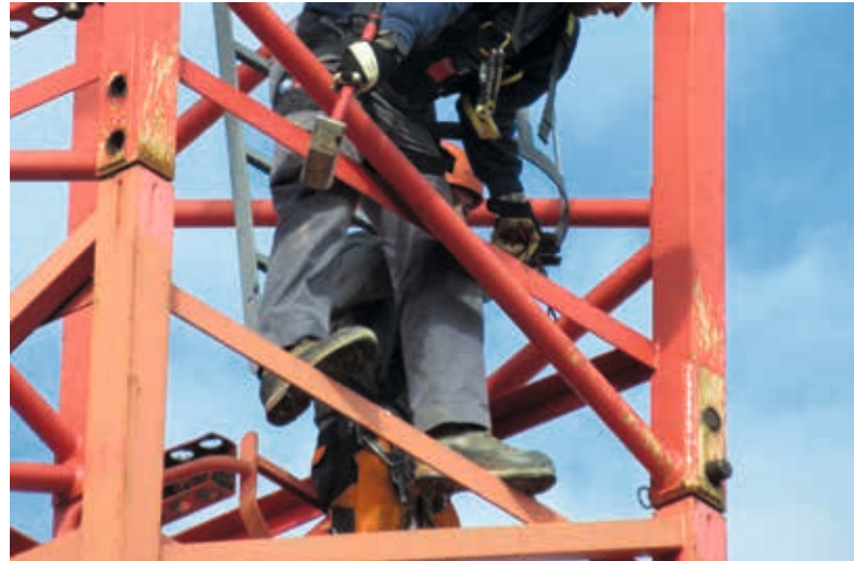
Rechts steckt noch der untere Sicherungsbolzen bis zum Anhängen des Turmelements am Pneukran, links sind beide entfernt.
