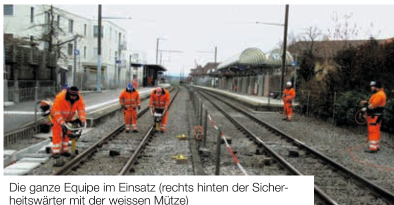
Gleisarbeiter verdichtet den Schotter unter den Schienen mit einem motorbetriebenen Vertikal-Schwingstopfer.
