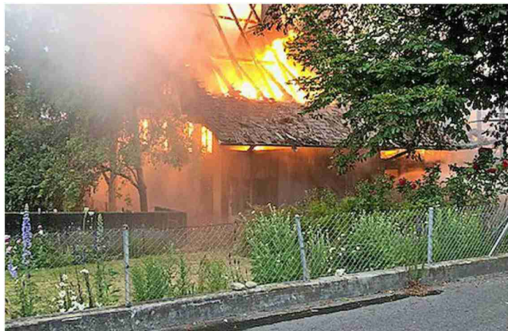
Als die Einsatzkräfte eintrafen, stand das Gebäude bereits in Vollbrand. Foto: Kantonspolizei Bern
