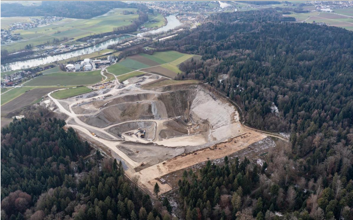
In der Kiesgrube von Walliswil-Bipp ist Bohrschlamm abgelagert worden. Die sei zwar illegal, für die Umwelt aber kein Problem, sagt der Kanton. Foto: Beat Mathys
