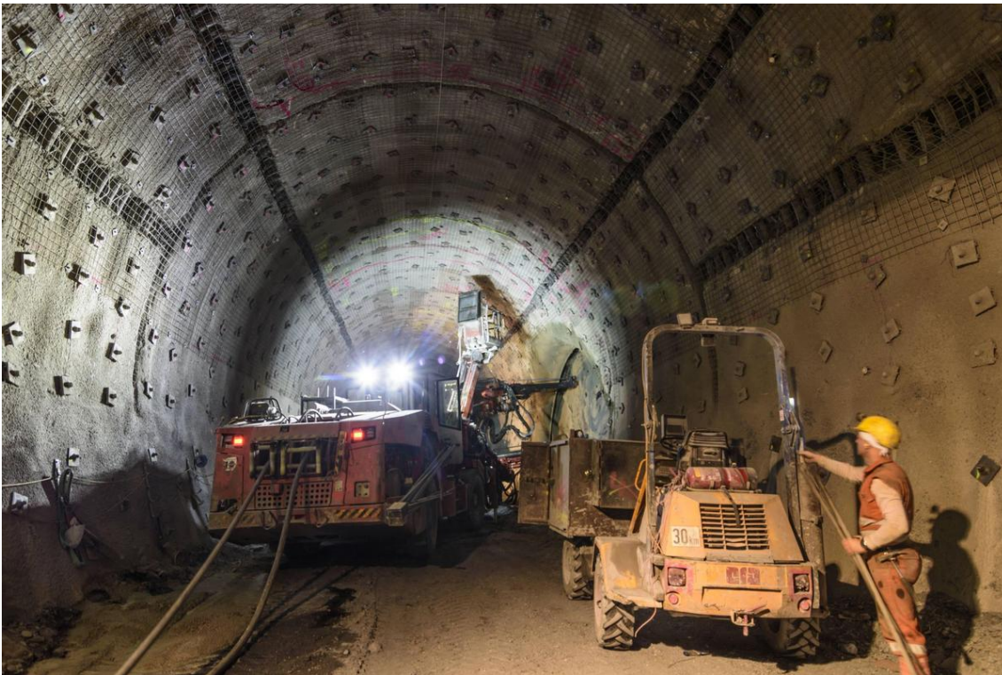
Arbeiten für den neuen Basistunnel der Österreichischen Bundesbahnen: Beim Baulos unter Schweizer Führung wurde Material und Treibstoff in Millionenhöhe abgezweigt. Foto: Volker Preusser (Imago)
