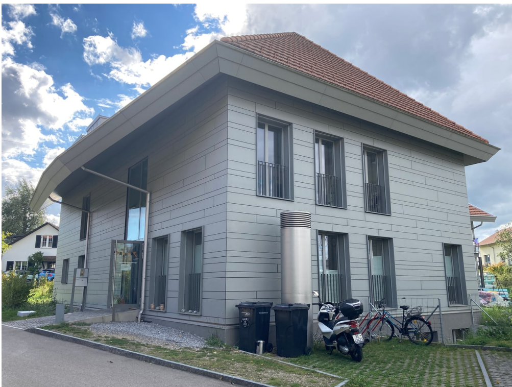
Das Zentrum für Essstörungen befindet sich in Moosseedorf in einem Neubau.
