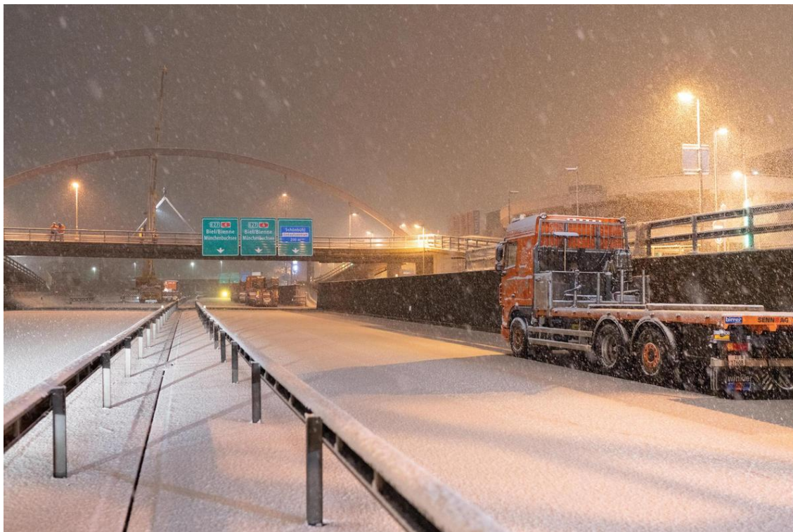
Kurz vor Schluss der Arbeiten um fünf Uhr morgens. Auf den Strassen liegt bereits eine dicke Schneeschicht. Foto:
