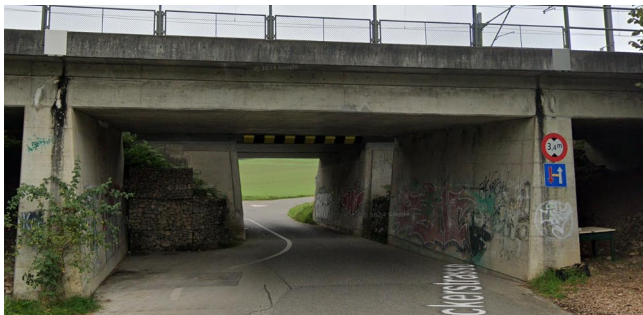
Abbildung 3: Unterführung Gleise, Blickrichtung Süden, SBB-Gleis im Foto hinten, RBS-Gleis im Foto vorn
