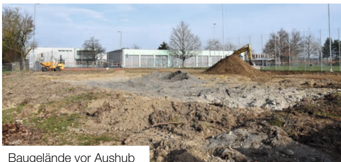
Baugelände vor Aushub
