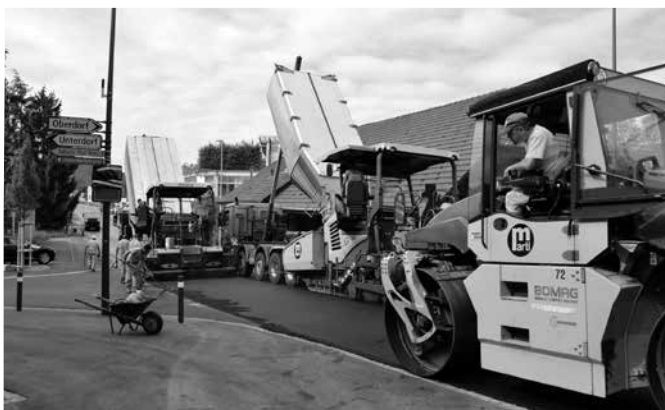
Belagseinbau am «Ochsenstutz»
