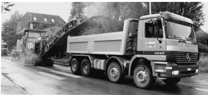
Ausfräsen und Verladen des alten Belages
