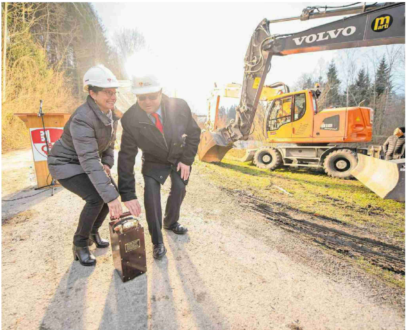
Die beiden Obwaldner Regierungsräte Maya Büchi und Josef Hess eröffnen mit einer symbolischen ersten Sprengung die Bauarbeiten für den Hochwasserentlastungstollen. Bild: Urs Flüeler/Keystone (Alpnach, 10. Februar 2018)
