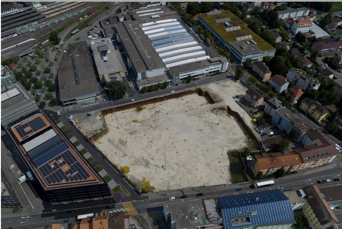
Ende Jahr sollen hier die Bauarbeiten für den neuen Campus der Berner Fachhochschule in Biel beginnen. Bis es soweit ist, braucht es noch zwei politische Entscheide. Foto: Raphael Moser
