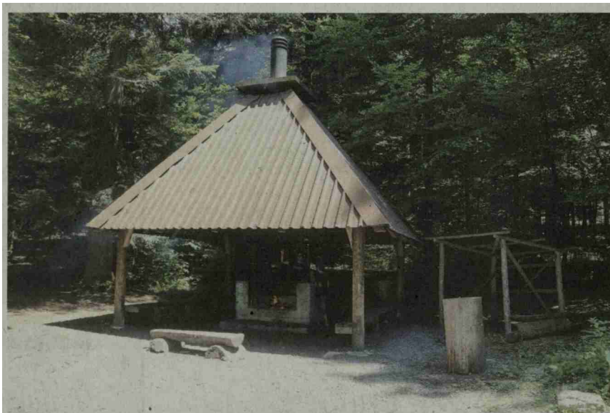
Verspricht Kühle an heissen Tagen: die Brätlistelle Urtenen-Schönbühl.
