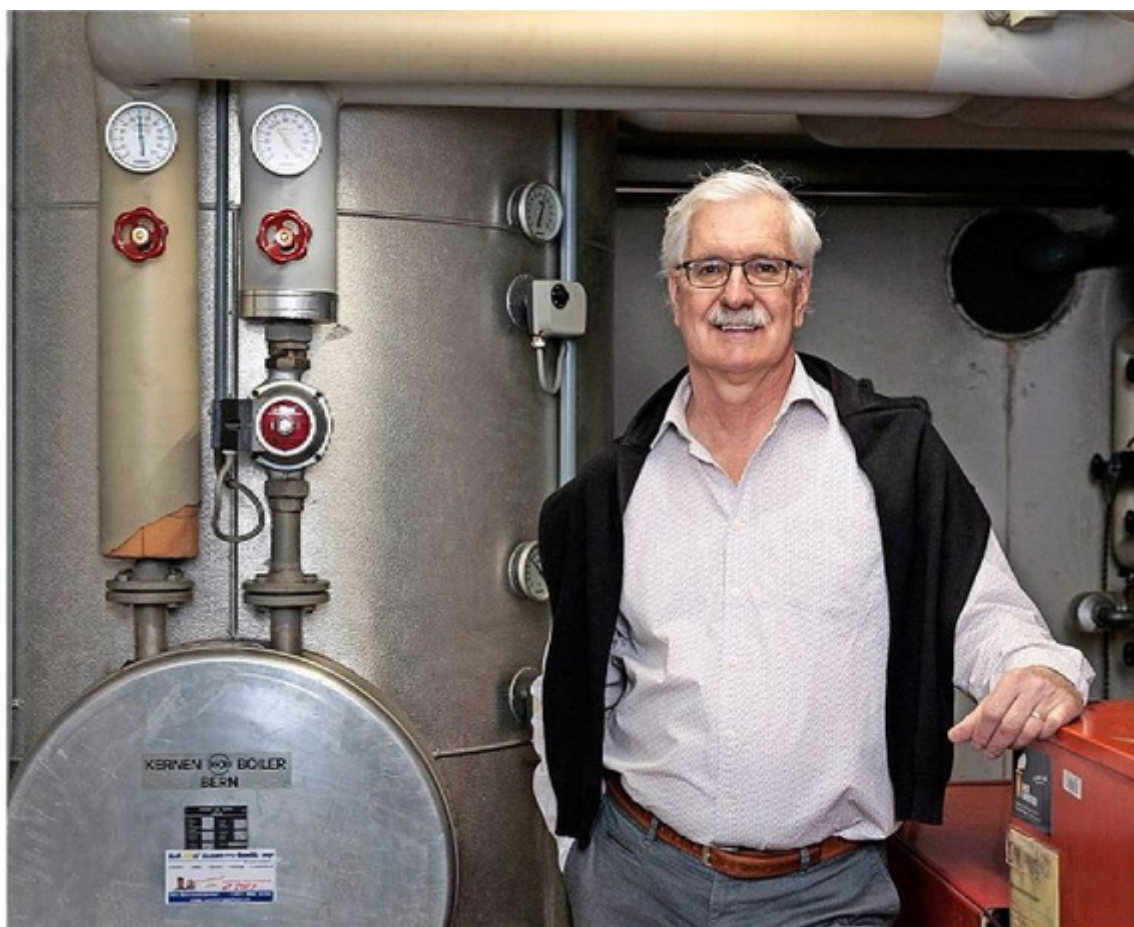
Boiler sollen tagsüber aufgeladen werden, fordert Roland Lüthi, GLP-Grossrat und Leiter einer Haustechnikfirma. Foto: Christian Pfander
