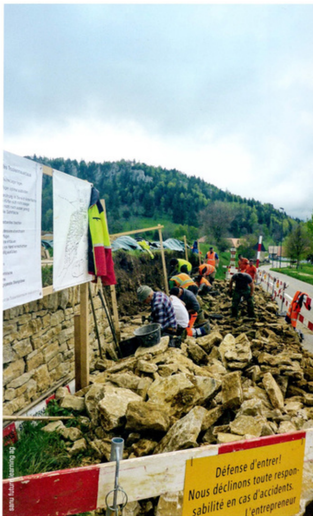
Vorbereitung für den Bau einer Trockensteinmauer in St. Brais, Jura. Travaux préparatoires à la construction d'un mur en pierres sèches à Saint-Brais (JU).
