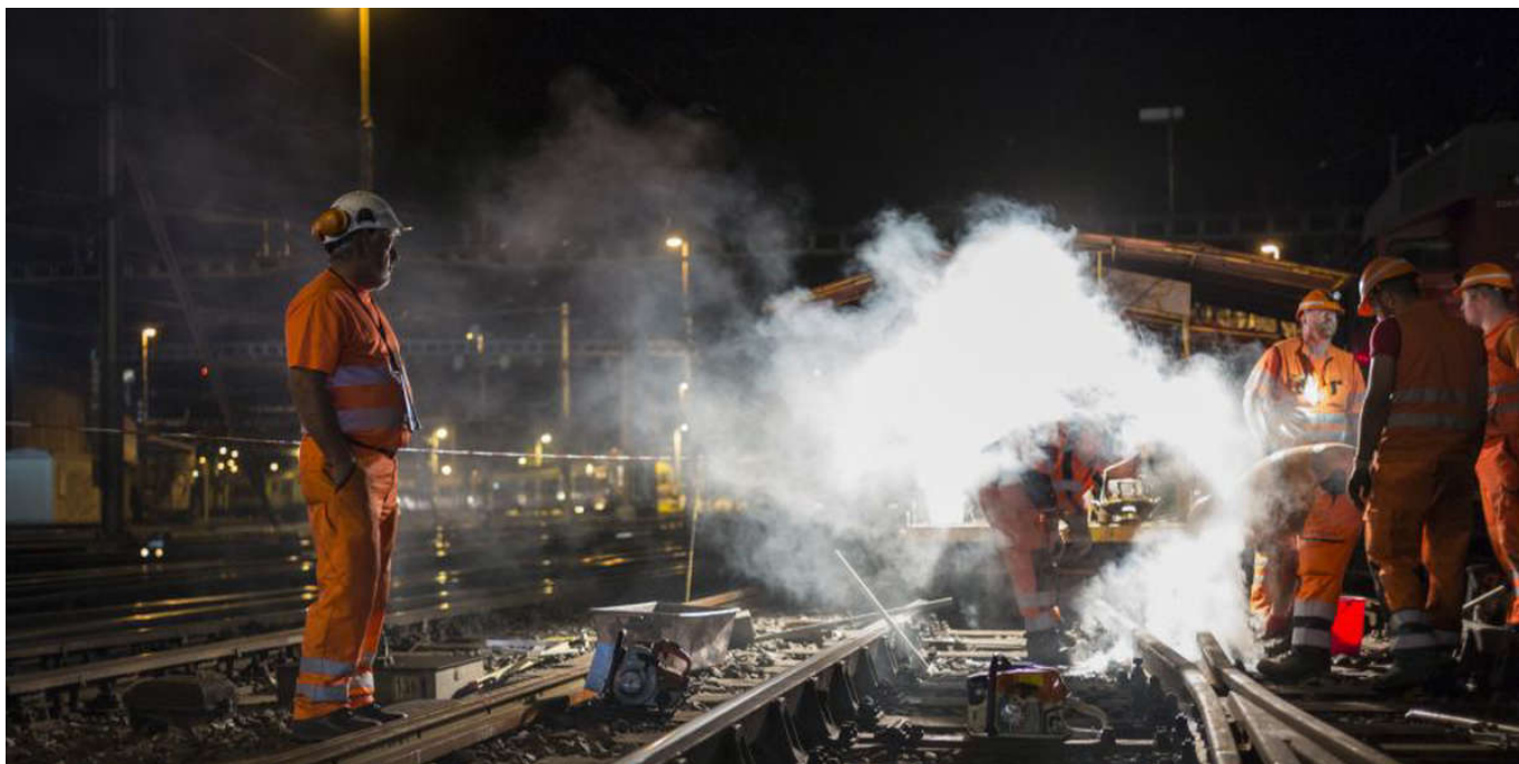
Die Gleisarbeiter sind oft nachts im Einsatz – zum Unmut mancher Anwohnenden. - keystone
