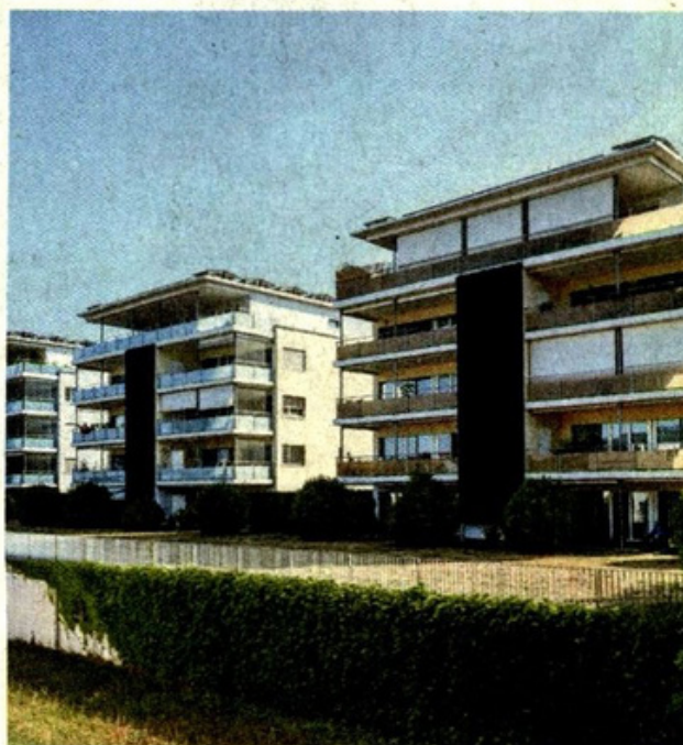
saniert – inklusive PV-Anlage und Erdsonden-Wärmepumpe
